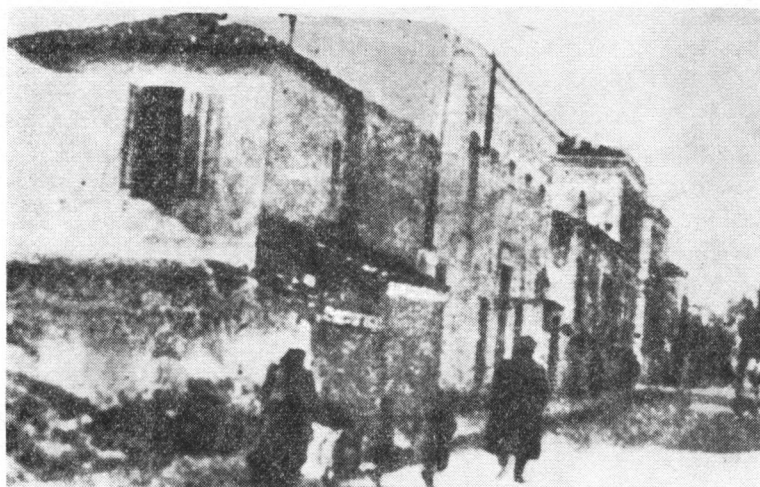
20. Η κατοικία του Δελμούζου στο Βόλο
